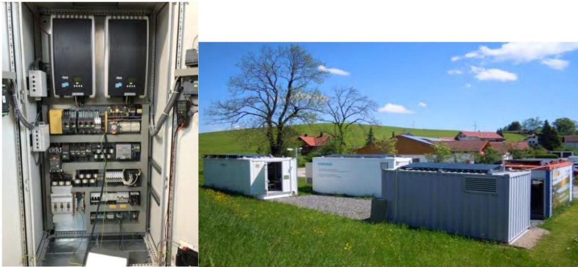
Abb. 6: Energie Campus Wildpoldsried (ECW) mit PV-Anlagen, stationärem Batteriespeicher, Gleichstromkurzkupplung und Control Center
